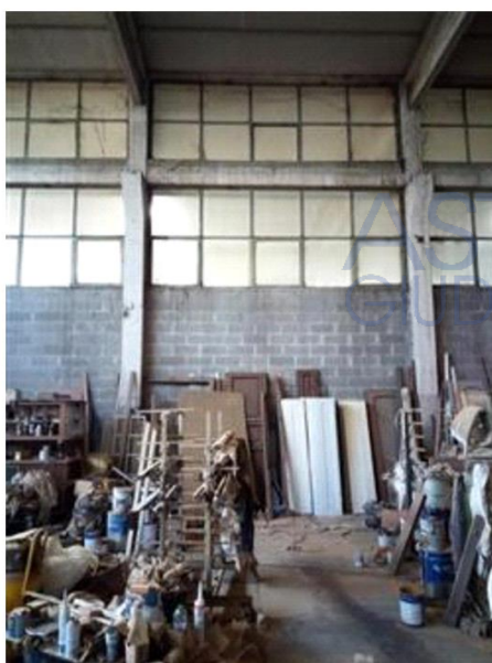
parete divisoria con la finestratura a nastro sovrapposta
