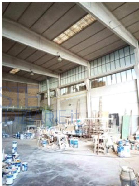
interno con evidenziata la struttura a capriata
