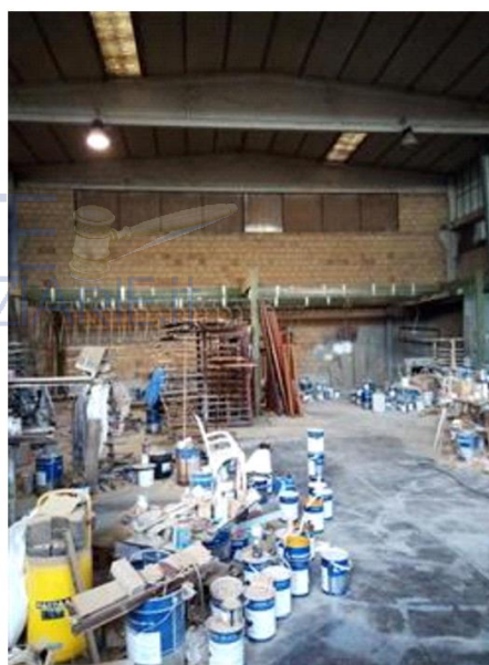
parete frontale all'ingresso in blocchi di laterizio e finestra a nastro superiore
