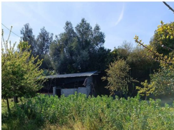
Foto 3: piccolo manufatto di circa 30,00 mq, coperto da tettoia, realizzato in aderenza al confine ovest della particella (vedi planimetria indicativa dello stato dei luoghi).
