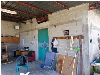
Foto 5: ingresso al deposito, protetto da tettoia.
