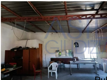
Foto 6: interno del deposito. Nell'angolo a sinistra è stato realizzato un piccolo v.c.
