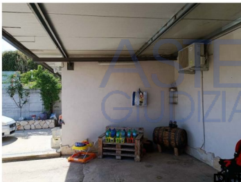
Foto 6: la facciata del lato sud dell'abitazione, identificata con la particella 923, è stata intonacata e rifinita con grassello di calce.
