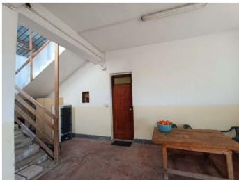
Foto 7: Catasto Terreni di San Ferdinando, foglio 17, particella 654, Contrada Focoli. Atrio di collegamento tra i sub 2 e sub 3 e vano scala che conduce al sub 4.
