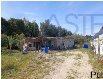
Foto 4: deposito di circa 50,00 mq, con annessa tettoia.
