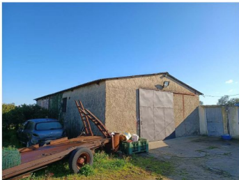
Foto 3: Catasto Terreni di San Ferdinando, foglio 17, particella 653, Contrada Focoli. Deposito.
