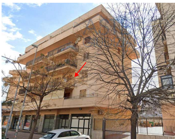
Foto Google - Street View (prospettiva da Via C. Borromeo)
