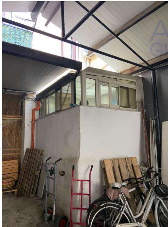
Foto 17 - vista dall'esterno della veranda/cucina
