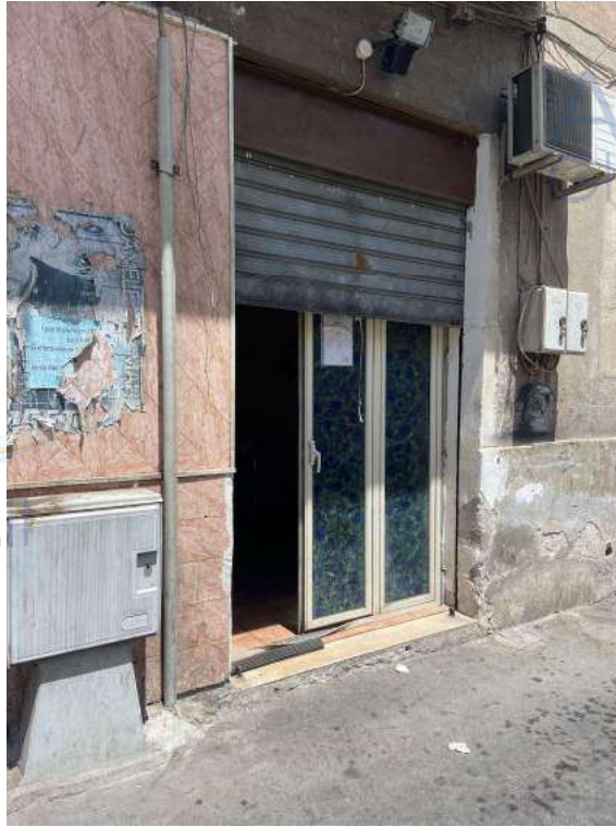
Foto 6 - vista ingresso dell'immobile dal civ. 111
