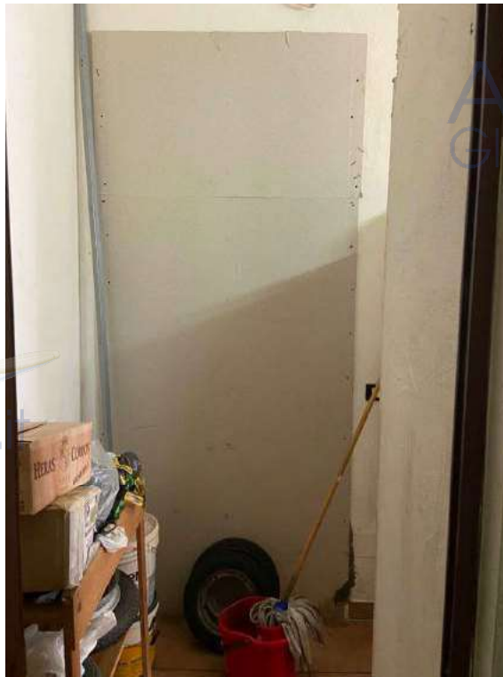
Foto 10 – vista della pannellatura interna che interdice l'accesso al ripostiglio
