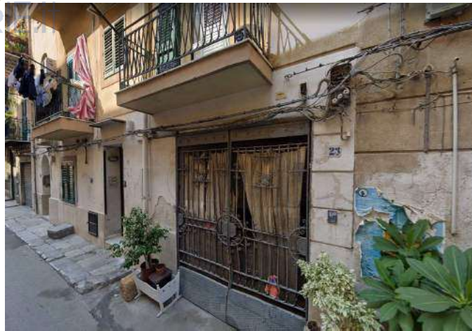
Foto 12 - vista dell'ingresso dell'edificio dalla via Rosina Muzio Salvo n. 23
