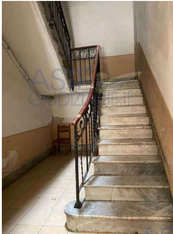
Foto 24 - vista della scala all'interno dell'androne condominiale
