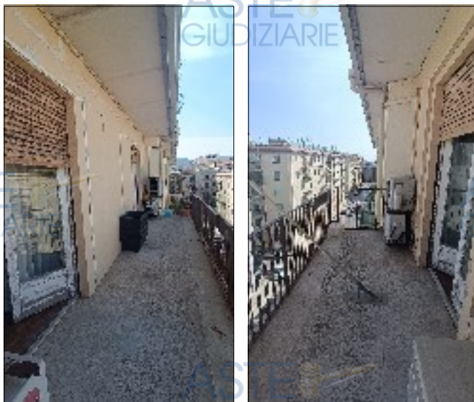
Balcone su via Marsala Balcone su via La Farina
