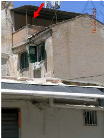
Foto 25 - Terrazza piano 3° vista da via G. Verga
