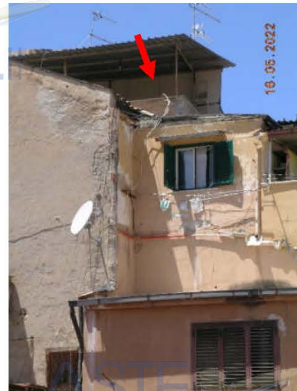
Foto 26 - Terrazza piano 3° vista da via G. Verga
