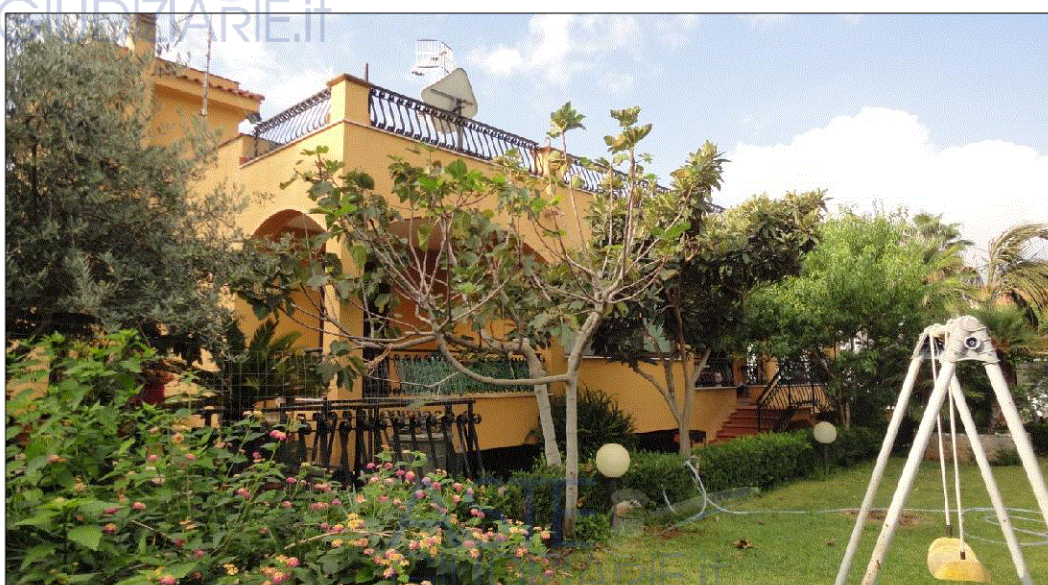
Prospetto principale del fabbricato
