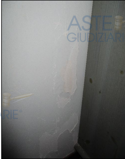
Foto 18 – Scrostamenti della tinteggiatura
