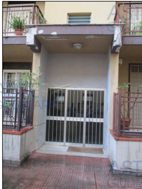
Foto 4 – Accesso alla scala B - Palazzina C
