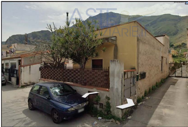
Foto 2 – Vista laterale dell'edificio
