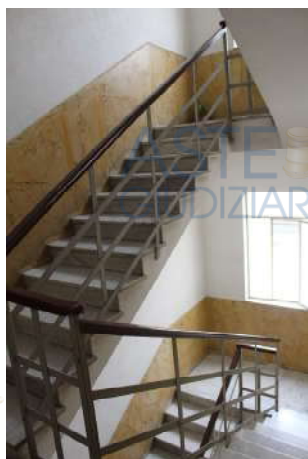
Corpo scala condominiale
