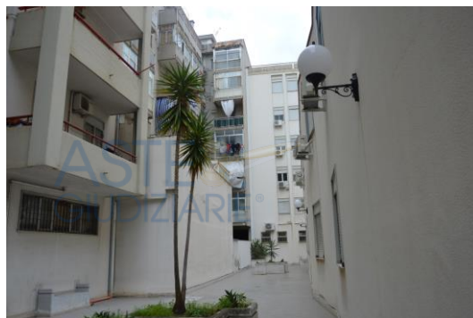
Foto n. 2 Area esterna condominiale
