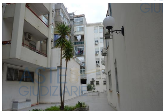
Foto n. 2 Area esterna condominiale
