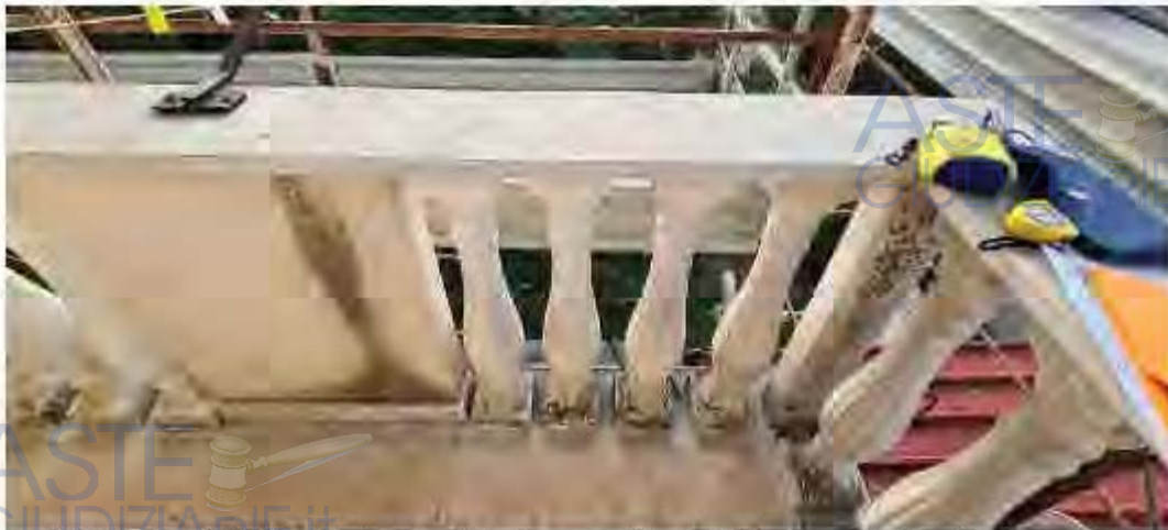
Balaustra di delimitazione del balcone e lavori rifacimento facciate in corso
