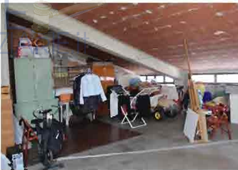
Vista della porzione di sottotetto non rifinita
