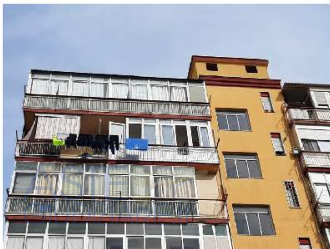
Veranda cucina vista dall'esterno
