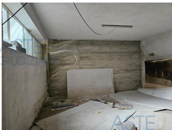
Foto 16 – vista del piano S2
