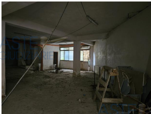
Foto 15 – vista del piano S2
