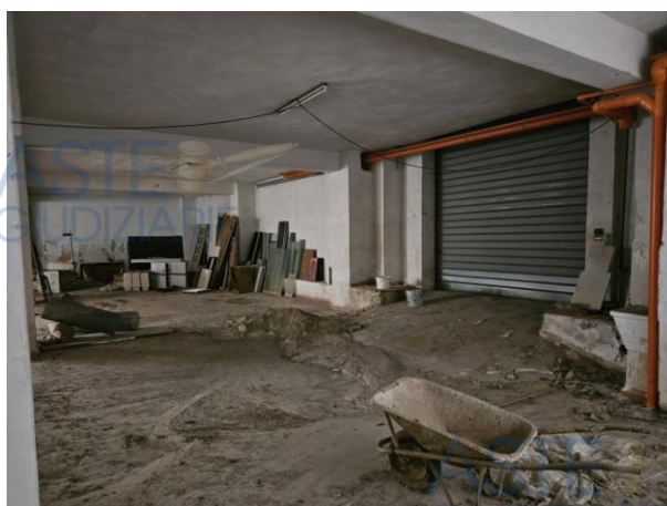
Foto 17 – vista del piano S2
