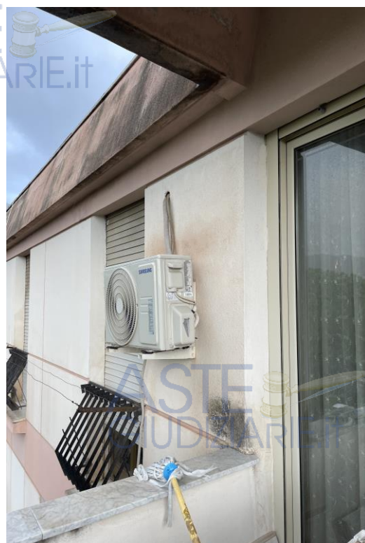
Foto 14 – Il balcone sul prospetto posteriore, con evidenti macchie dovute a infiltrazioni d’acqua Foto 15 – Foto dal balcone del prospetto sul retro
