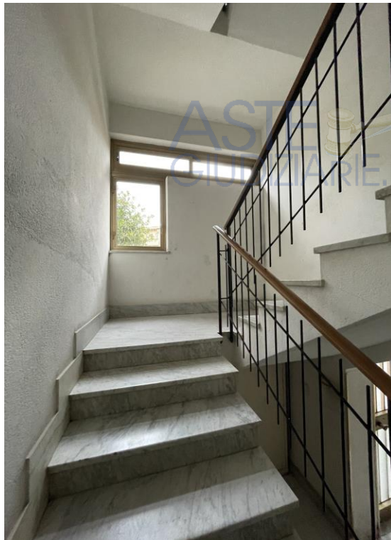
Foto 5 – La scala di accesso al 3° piano senza ascensore
