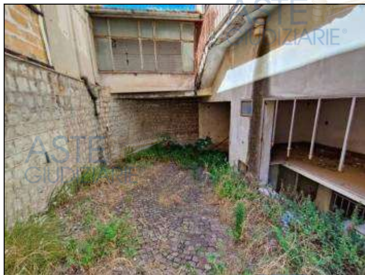
Rampa di accesso al piano cantinato
