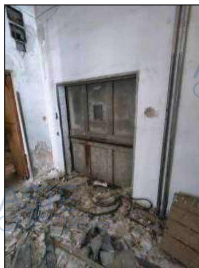
Montacarichi al primo piano
