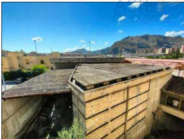
Copertura in eternit della cella frigorifera trapezoidale e della tettoia
