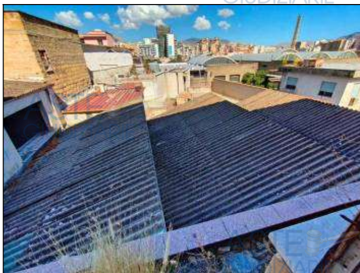
Copertura in eternit di una porzione del corpo "A"
