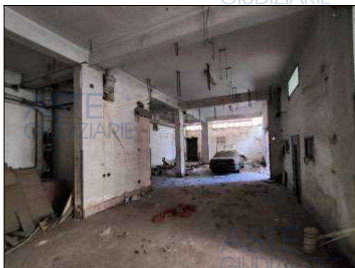
Sala posta al piano cantinato
