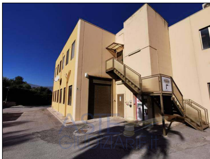
Magazzino di piano terra e scala di collegamento con il piano primo (sub. 3)
