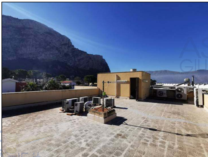
Terrazza della palazzina uffici (sub. 2)
