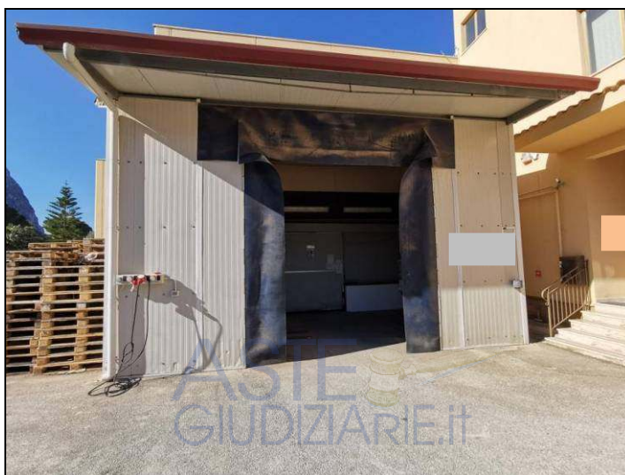
Tettoia di accesso alla cella frigorifera di piano terra (sub. 2)
