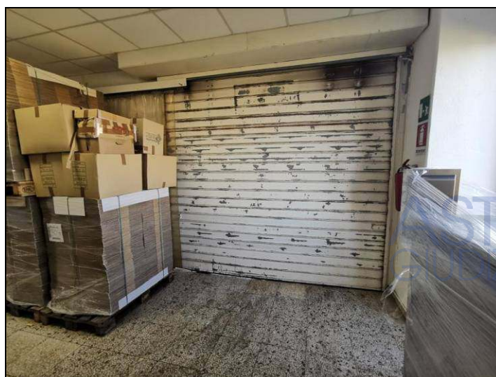
Accesso al primo piano mediante rampa carrabile (sub. 3)
