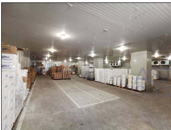
Interno della cella frigorifera di piano terra (sub. 2)
