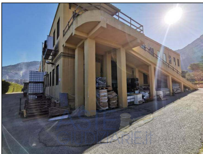
Porzione di fabbricato afferente al sub. 3 con rampa di accesso al primo piano
