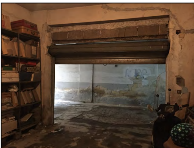
Fig.15 Veduta dall'interno del garage
