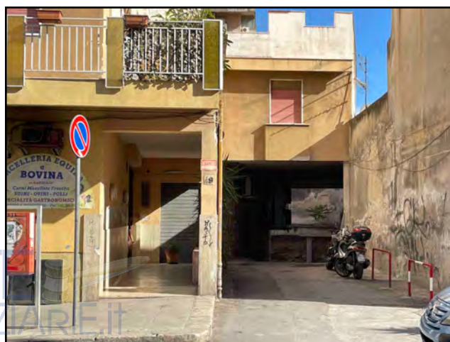
Fig.6 Accesso al piano scantinato civ.46
