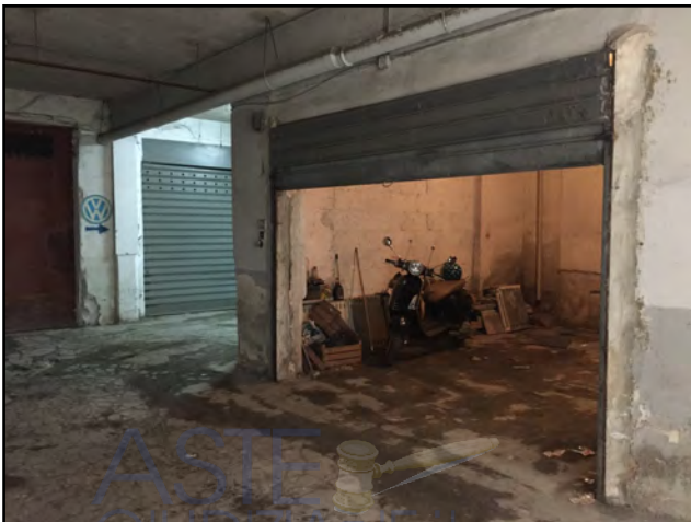
Fig.11 Veduta dalla corsia di disimpegno
