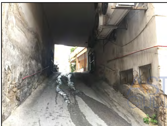
Fig.7 Rampa di accesso al piano scantinato
