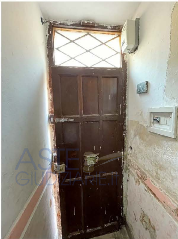
Ingresso piano terra
