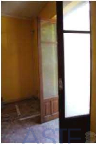
Particolare infisso esterno Vano (2)
