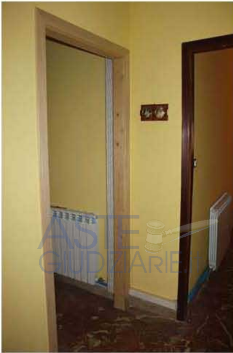
Accesso al corridoio dal vano ingresso
