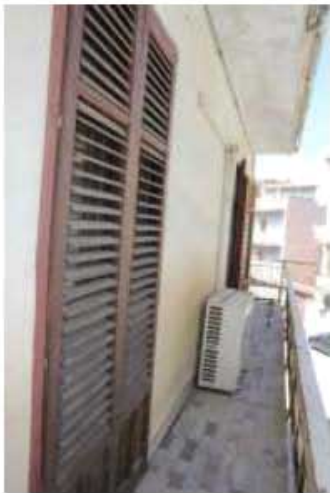
Balconcino su via C. Di Bella
