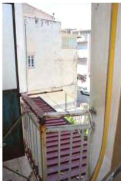
Particolare della porzione di Balconcino
