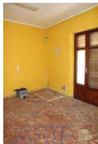
Vano (2) posto a nord-ovest
