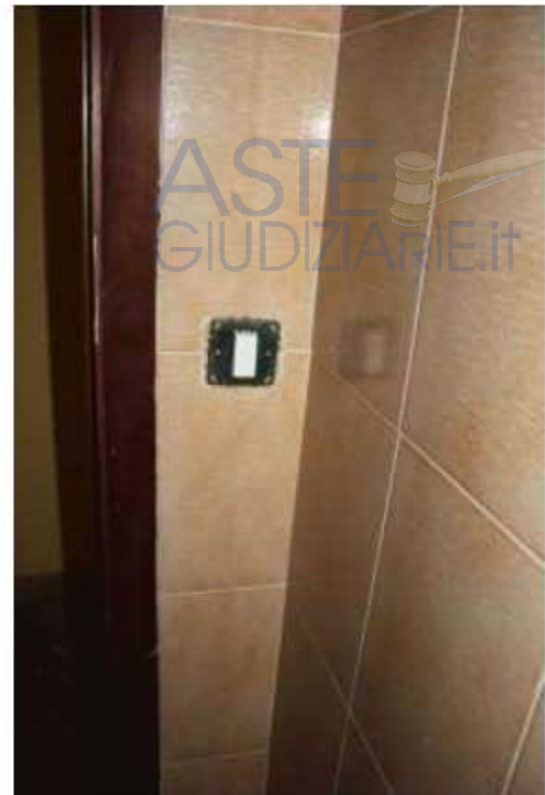
Particolare rivestimento bagno
