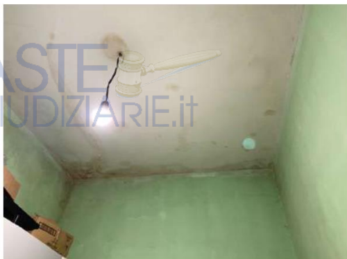
Foto n. 11 – soffitto e pareti stanza da letto
