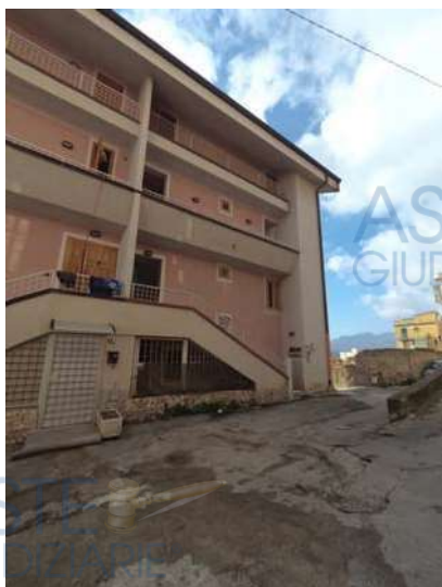
Figura 2: Vista fabbricato da via Salita Sant'Antonino
