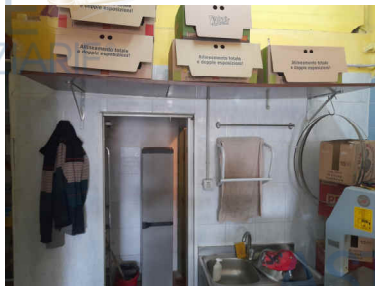
Foto 8 Accesso al wc
