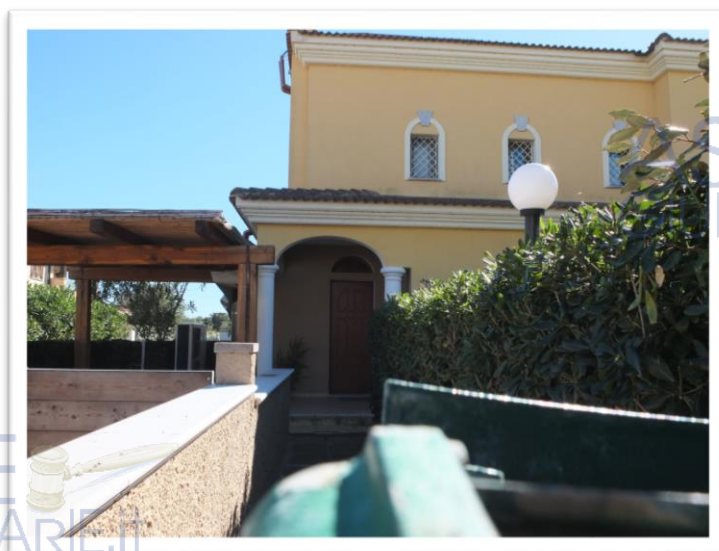
Vista dell'ingresso al piano terra
