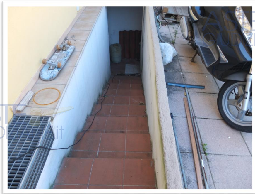
Scala esterna accesso piano interrato
