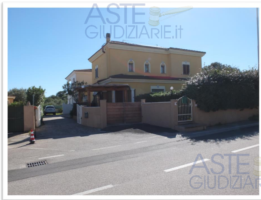
Vista dello stabile dall'esterno su via Montale
