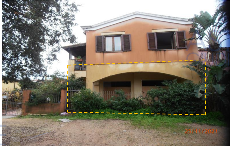
Esterno locale commerciale
