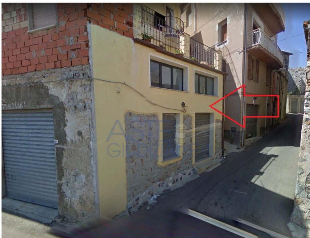
Foto vista esterna locale al foglio 38 particella 1364 sub 2
