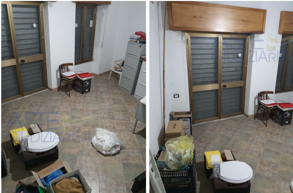
Foto vista interna locale al foglio 38 particella 1364 sub 2
