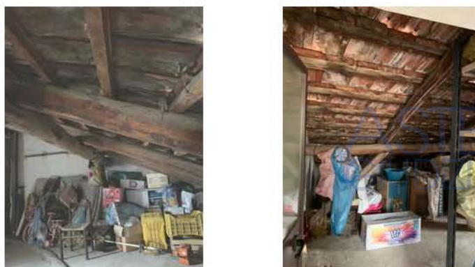
Vista interna del piano sottotetto
