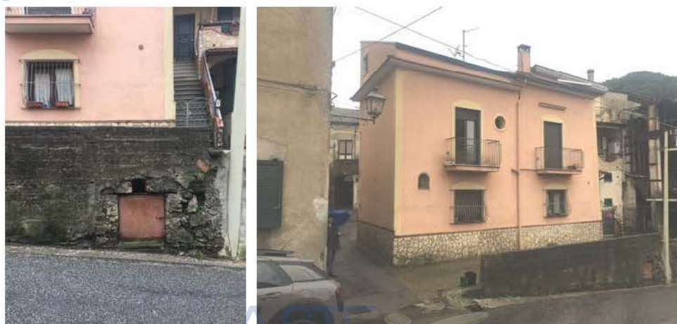
Vista del fabbricato dalla strada provinciale
