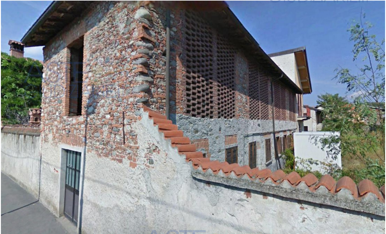
prospetto fabbricato principale
