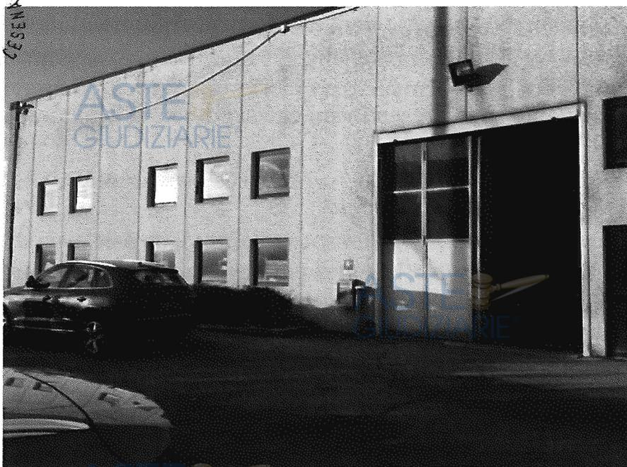
Le **tamponature verticali** esterne sono realizzate da **pannelli modulari prefabbricati** verticali con superficie esterna di finitura in ghiaia lavata.
