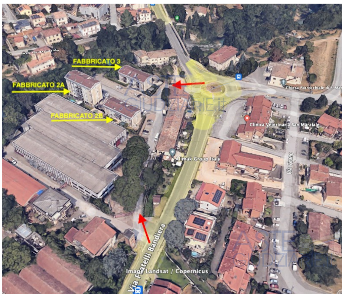
Foto n. 3 – Panoramica complesso residenziale
