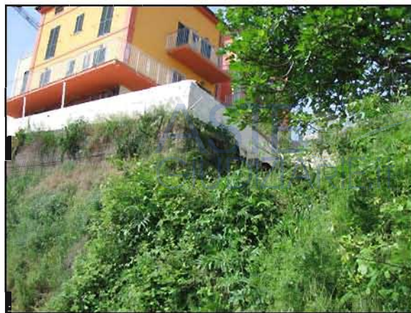
Foto 2 del 2009 il rilevato in terra armata ed il muro in c.a. soprastante
