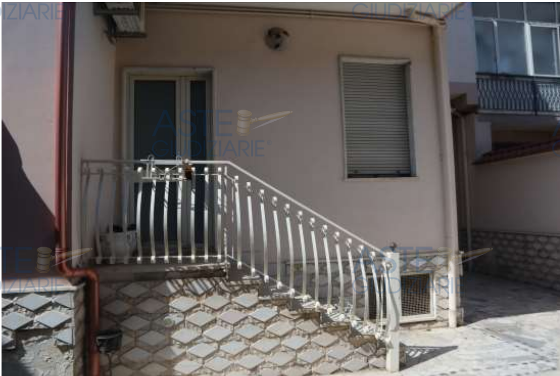
BALCONCINO SU CORTE INTERNA
