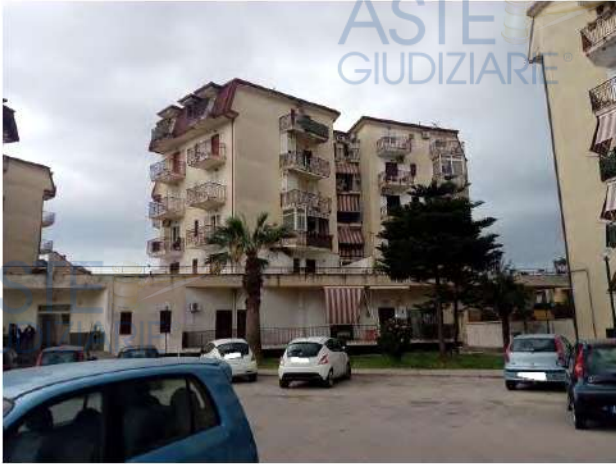
Vista d'insieme del fabbricato A
