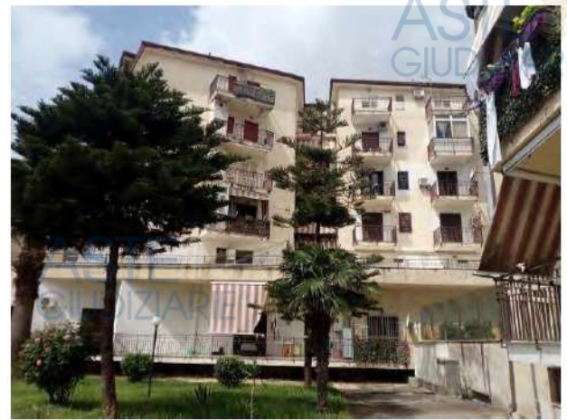
Altra vista del fabbricato A
