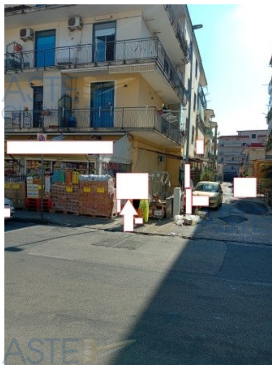
Figura 4 accesso da via Napoli n.95 Mugnano di Napoli
