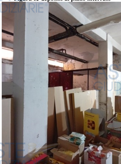
Figura 15 deposito al piano interrato
