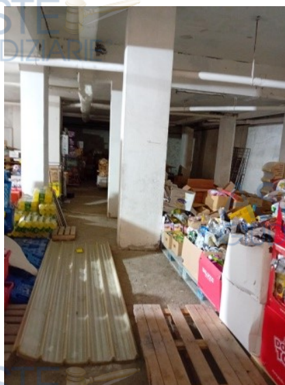
Figura 13 deposito al piano interrato
