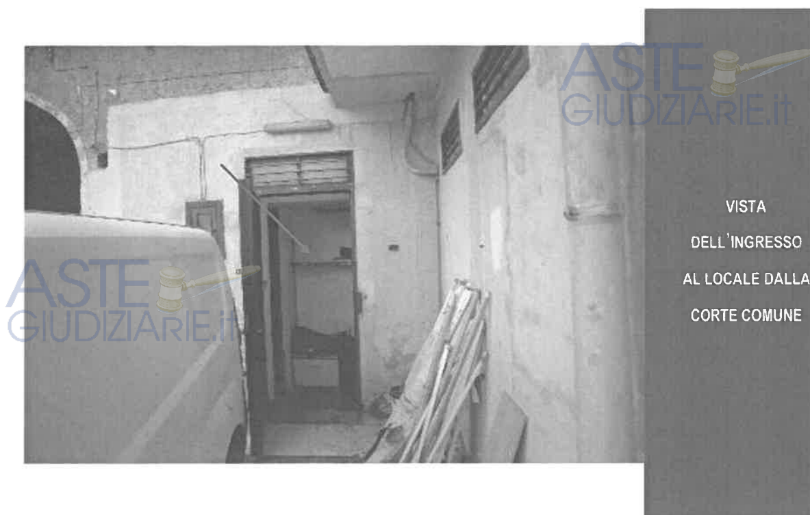
FOTO 1 - 2 - 3 - 4 Viste esterne del locale commerciale
