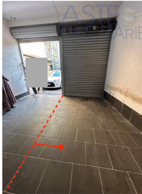
Foto n.4 – particolare locale autorimessa
