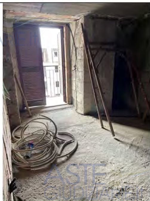
Fotografia n. 10 _ Vano con affaccio a sud
