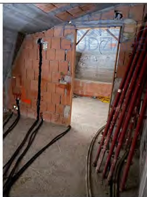
Fotografia n. 12 _ Vano a destra dell'ingresso
