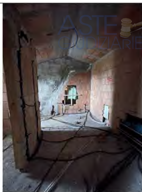
Fotografia n. 12 _ vano con affaccio a nord
