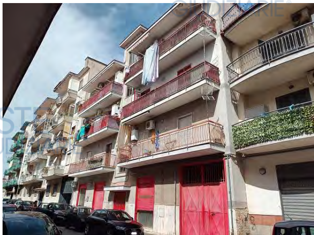
Il fabbricato visto da Via Libertà
