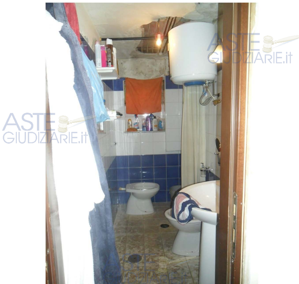
Vista interna - Bagno
