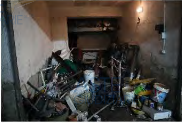
Vista interna del box auto
