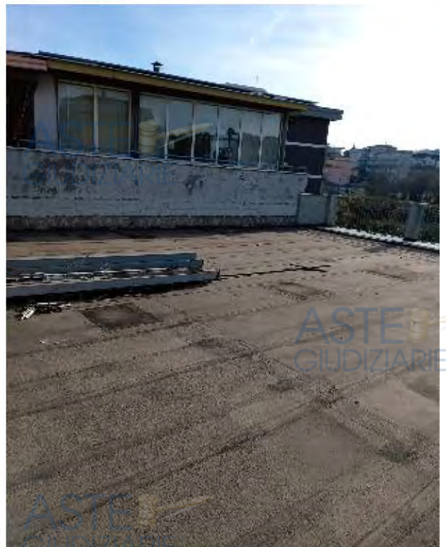
Viste esterne del lastrico solare
