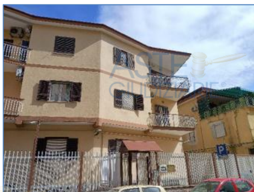
Fotografia 1 – Prospetto su via Galilei
