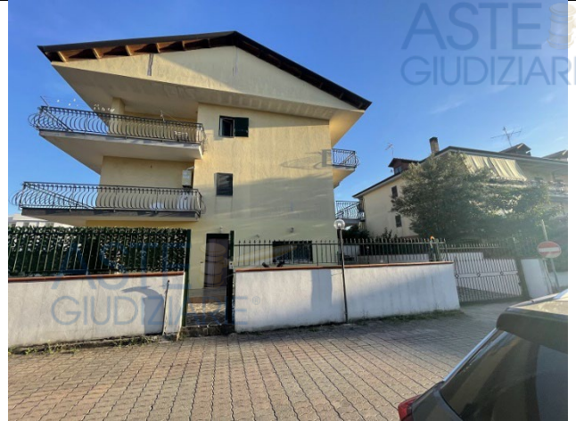
Vista dal cortile condominiale sub 1
