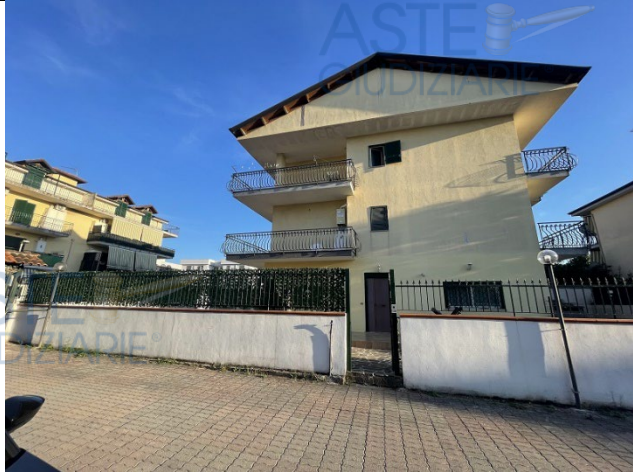
Vista dal cortile condominiale sub 1
