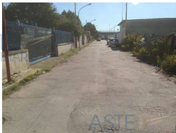
Foto n.01, vista di Via I Traversa Ponte Riccio verso sud
