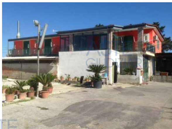
Foto n.14, vista sud – ovest del corpo di fabbrica
