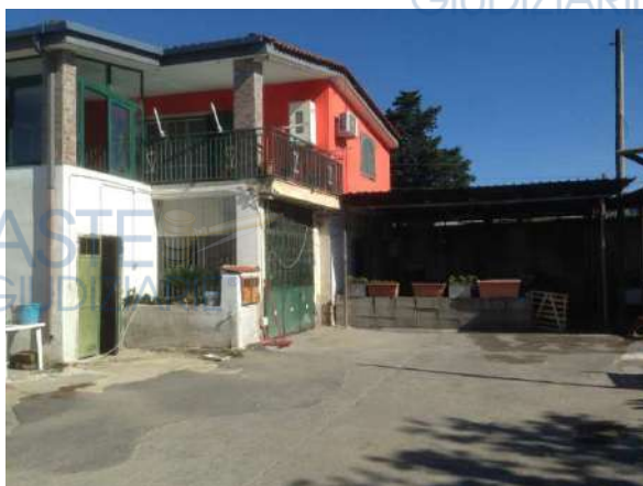
Foto n.15, vista lato sud del fabbricato di interesse, con i tre ingressi a piano terra (al sottoscala, all'atrio e alla cucina - pranzo)
