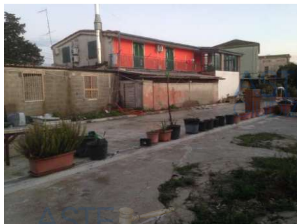
Foto n.20, vista nord – ovest del corpo di fabbrica
