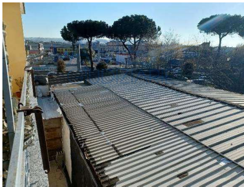
L'ampliamento abusivo del capannone ottenuto coprendo l'area libera laterale
