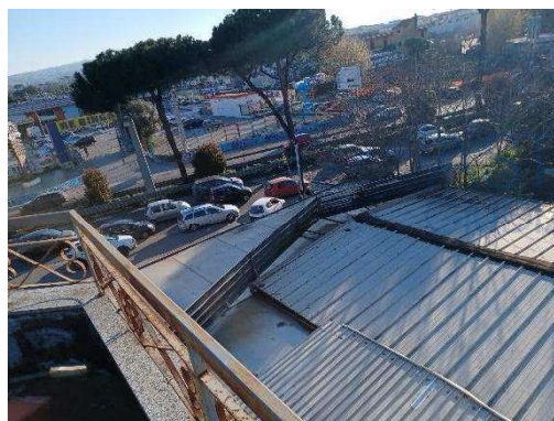
la copertura in lamiera sagomata
