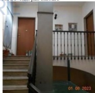
Foto n. 5 - Ultimo piano della scala B
