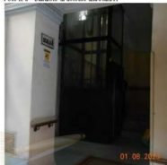
Foto n. 3 - Ballatoio di accesso alla scala A
