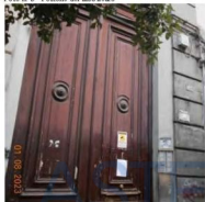
Foto n. 2 - Portone del fabbricato
