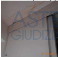
Foto n. 35- macchie di umidità in prossimità di un ripostiglio
