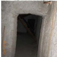
Foto n. 24 - Vani più interni adiacenti alla rampa di scale
