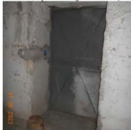
Foto n. 50 - Alto portoncino di ingresso al sottotetto (lato sud)
