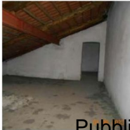
Foto n. 55 - Ambienti comunicanti sul fronte a nord
