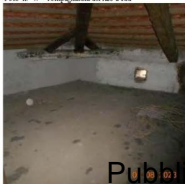
Foto n. 49 - Tramezzatura del lato a sud
