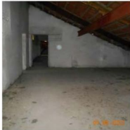
Foto n. 51 - Ambienti comunicanti sul lato ad est
