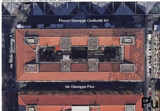
Foto n. 25 - Vista dall'alto delle mansarde in Napoli con accesso dalla Piazza Giuseppe Garibaldi 118, da via Giuseppe Ricciardi 10 e da via Silvio Spaventa 9
