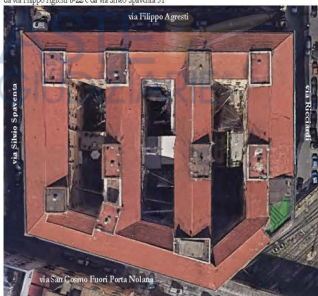
Foto n. 1 - Vista dall'alto delle mansarde in Napoli con accesso da via San Cosmo a Porta Nolana 37, da via Filippo Agresti 8-22 e da via Silvio Spaventa 51
