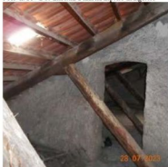
Foto n. 20 - Due ambienti a sinistra rispetto all'ingresso
