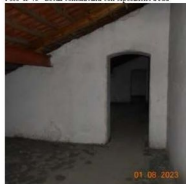
Foto n. 48 - Locali comunicanti con esposizione a sud
