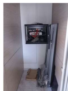
Foto n. 161 - Bagno n. 3 - sub 64
