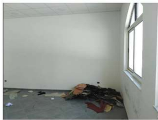
Foto n. 209 - Bene n. 7 - Sub 68
