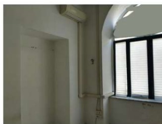
Foto n. 160 - Bagno n. 3 - sub 64
