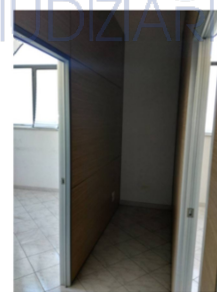
Foto n. 153 - Bagno n. 3 - sub 64
