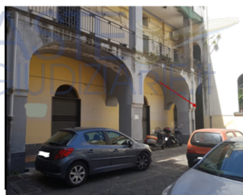
Foto n. 114 - Ingresso dal fabbricato interno cortile
