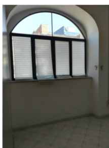
Foto n. 155 - Bagno n. 3 - sub 64
