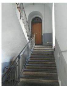
Foto n. 115 - Ingresso dalla scala condominiale
