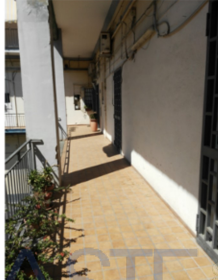
Foto n. 116 - Ingresso dal ballatoio condominiale
