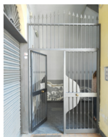
Foto n. 114 - Ingresso dalla scala condominiale
